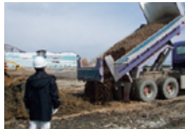
土砂展開場での目視検査
