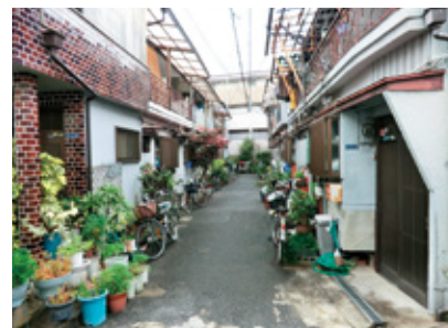
阪神・淡路大震災では死者約6,400人のうち約8割が建物の倒壊が直接の原因となっています。
