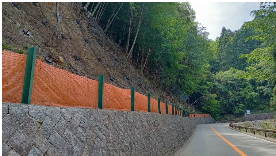
〔大阪北摂霊園幹線道路2号線法面对策工事〕
