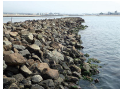
図2 干潟を取り囲む石積み護岸
