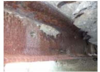
主桁：腐食（塗装劣化）、変形欠損
