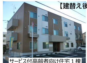
サービス付高齢者向け住宅1棟 (木造・3階建・30室)
