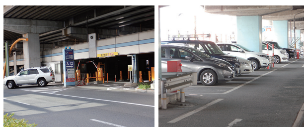
江坂南駐車場
