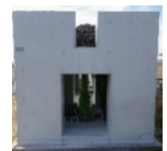
※1辺2mの立方体中空コンクリートブロックで、上部・内部に海域生物を誘引・逃げ隠れるための装置を配置
