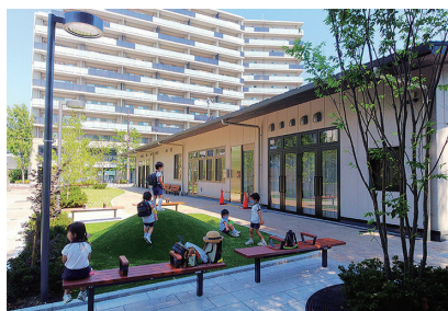
豊中市 新千里東町 西2地区 令和4年6月地区会館建築工事完了
