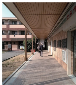
堺市南区 槇塚台 令和3年3月19日アーケード改修工事完了
