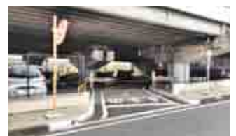
上新田駐車場
