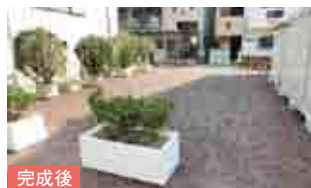
カラー舗装、植栽、防災倉庫が設置されています。
