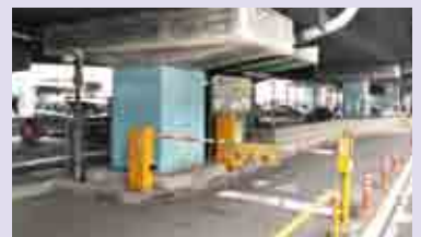
一条通西駐車場
