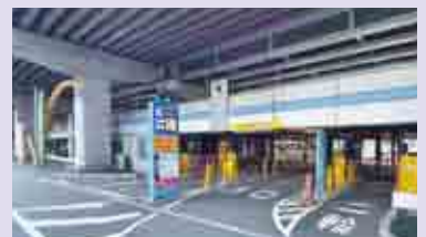
江坂南駐車場
