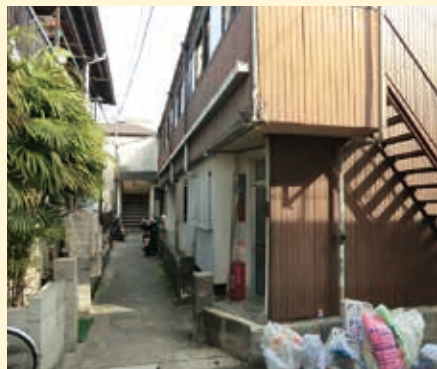
阪神・淡路大震災では死者6,400人のうち約8割が建物の倒壊が直接の原因となっています。
