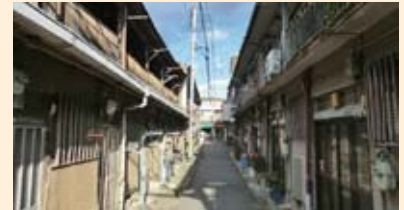
阪神・淡路大震災では死者6,400人のうち約8割が建物の倒壊が直接の原因となっています。
