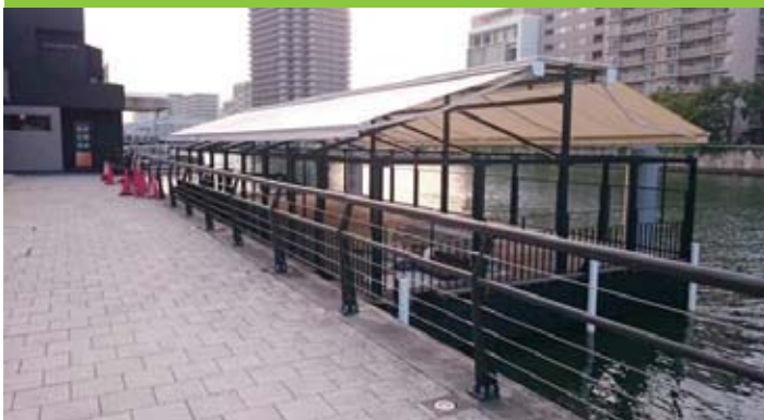
完成した全体像
