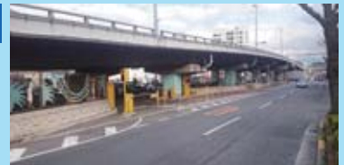
一条通西駐車場
