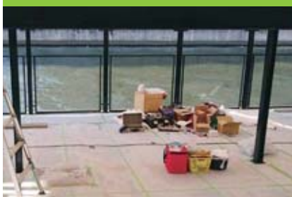
周囲に防音ガラスを設置
