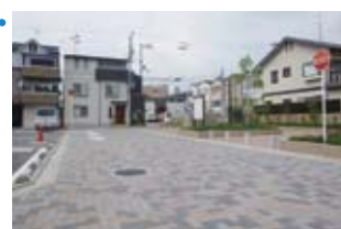
インターロッキング舗装
