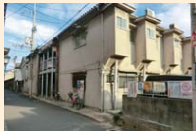
阪神・淡路大震災では死者6,400人のうち約8割が建物の倒壊が直接の原因となっています。
