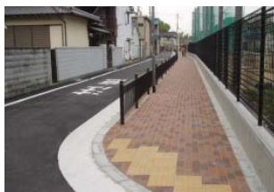
防災道路の整備
