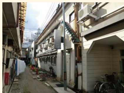
阪神・淡路大震災では死者6,400人のうち約8割が建物の倒壊が直接の原因となっています。
