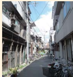
老朽木造住宅が密集して立地
