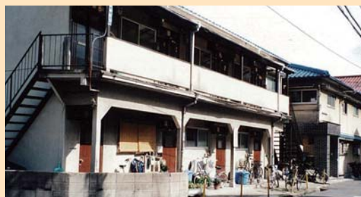
阪神・淡路大震災では死者6,400人のうち約8割が建物の倒壊が直接の原因となっています。
