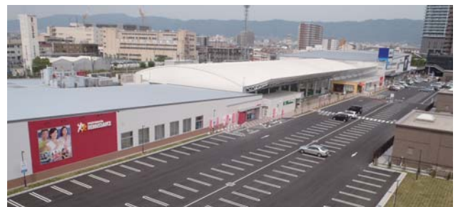
完成状況写真
