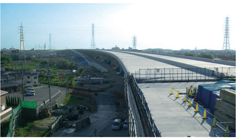
第二京阪道路の施工
