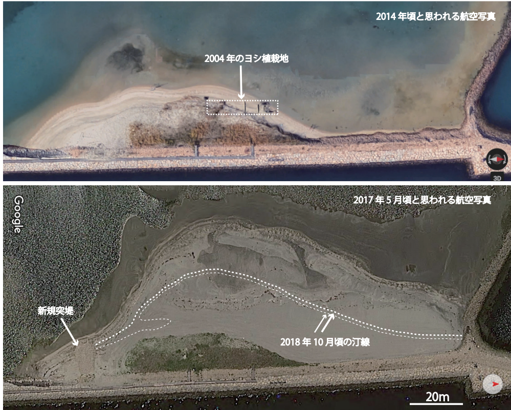
図 27. 航空写真で比較する阪南 2 区人工干潟の変化. 航空写真は「google マップ」による. 2014 年頃と思われる航空写真には, 波浪浸食が進み, 2004 年ヨシ移植実験の「遮水シート区」「矢板区」の基盤構造の残骸が露出しているのが見える. 2016 年度末に覆砂が追加されるとともに砂の消失を防止するために新規突堤が設けられた.
