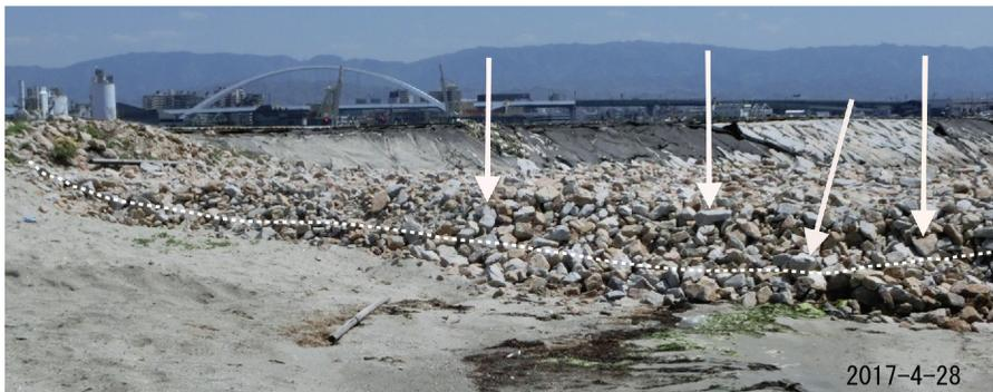
図 32. 2017年4月28日の突堤北側。矢印は写真解析の目印になりそうな石。破線は図33の砂に埋まった部分のおよその位置を示す。
