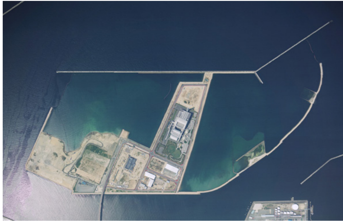
平成20年9月 浚渫土砂累積埋立量は、200万m 3 に達しました。
