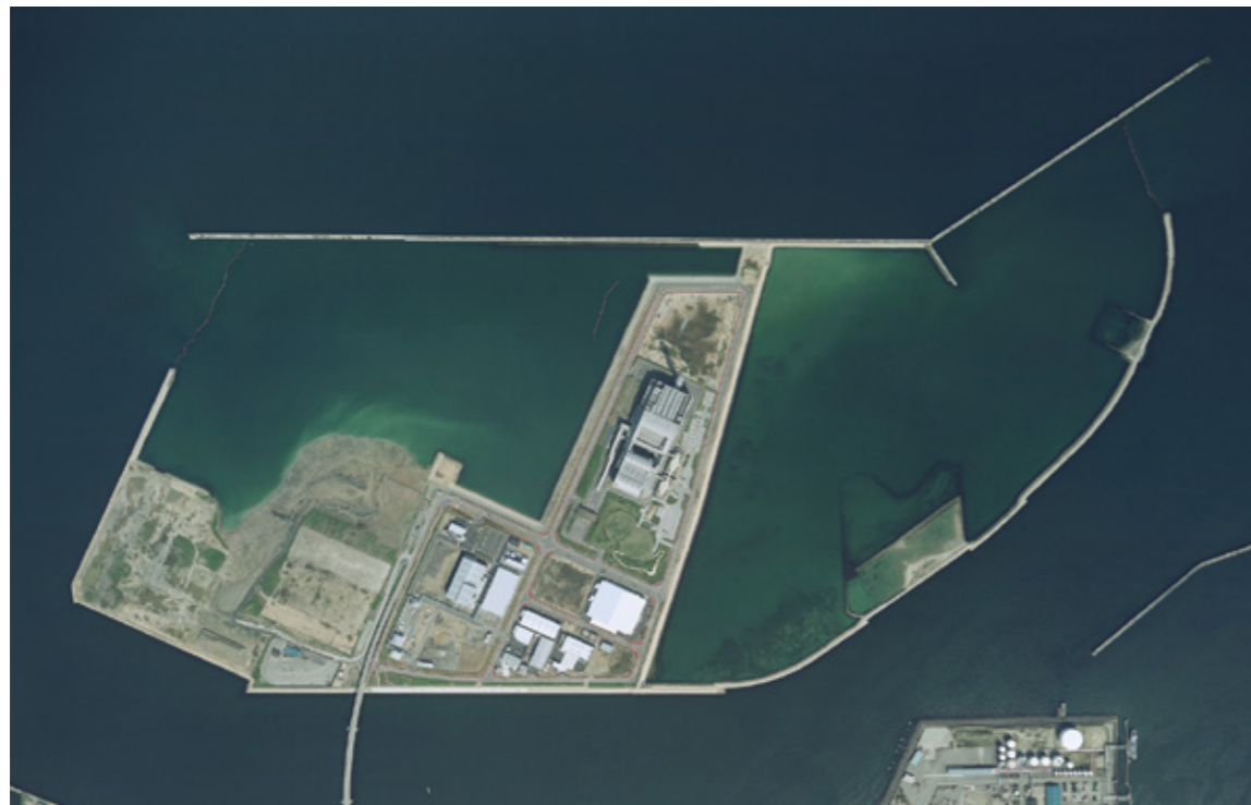
平成21年5月 岸之浦大橋が一般開放されています。第3-2-2区(第1期製造業用地)では、進出企業が操業中です。
