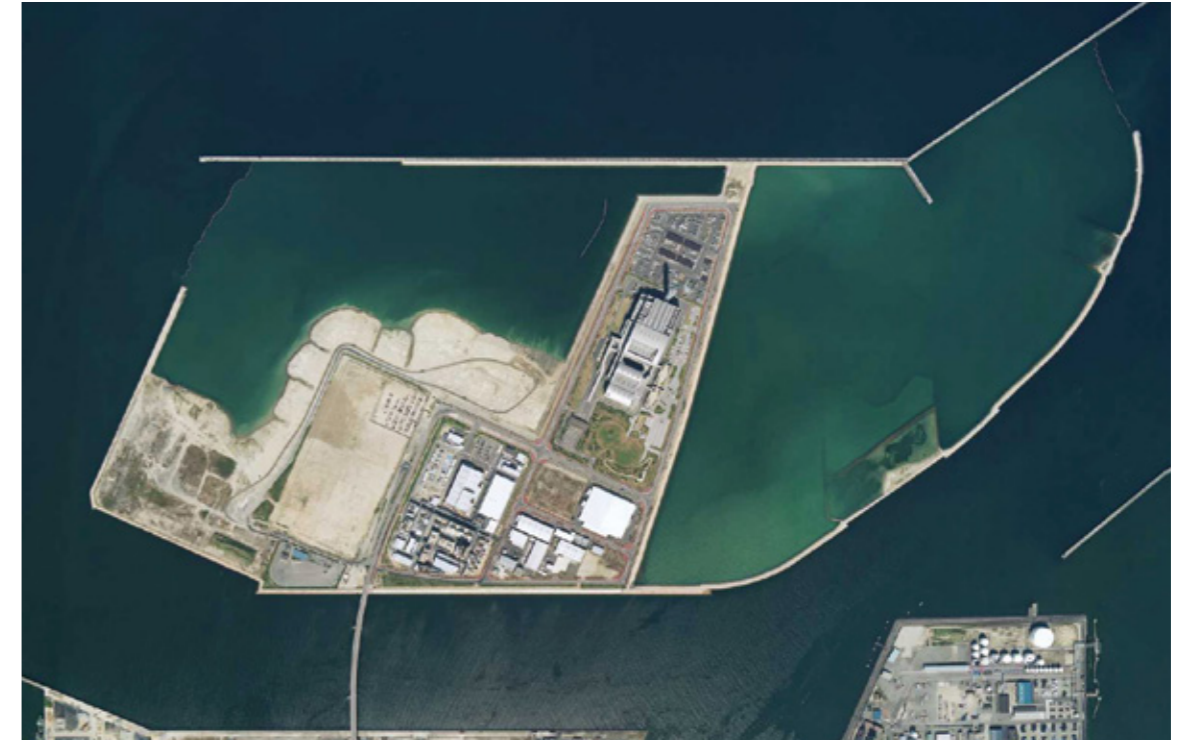
平成22年8月 第4-1区(第1期保管施設用地の一部)が竣工しています。建設発生土埋立区域は、第4-1区から第5-3-1区(第2期製造業用地)へ変更されています。
