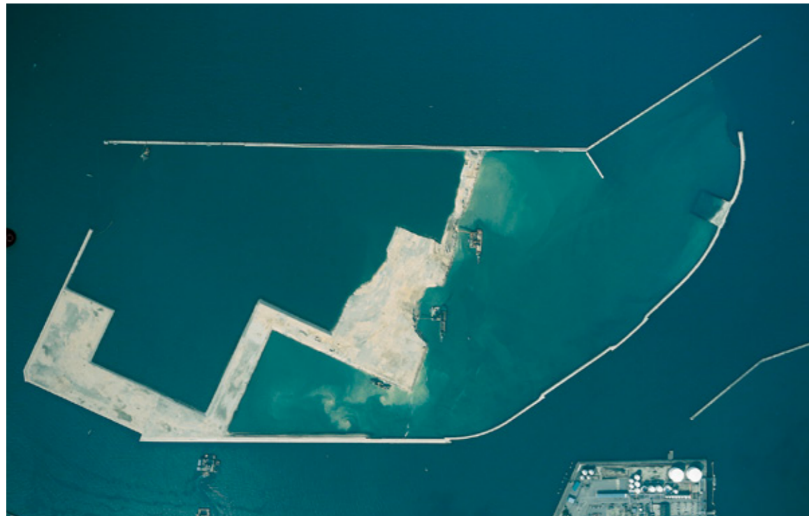
平成13年2月 緊急に用地造成が必要とされた第1-1区・第2-1区(幹線道路用地の一部)が、購入土(山土)等を用いて竣功し、北干潟(人工干潟実験区)も完成しています。
