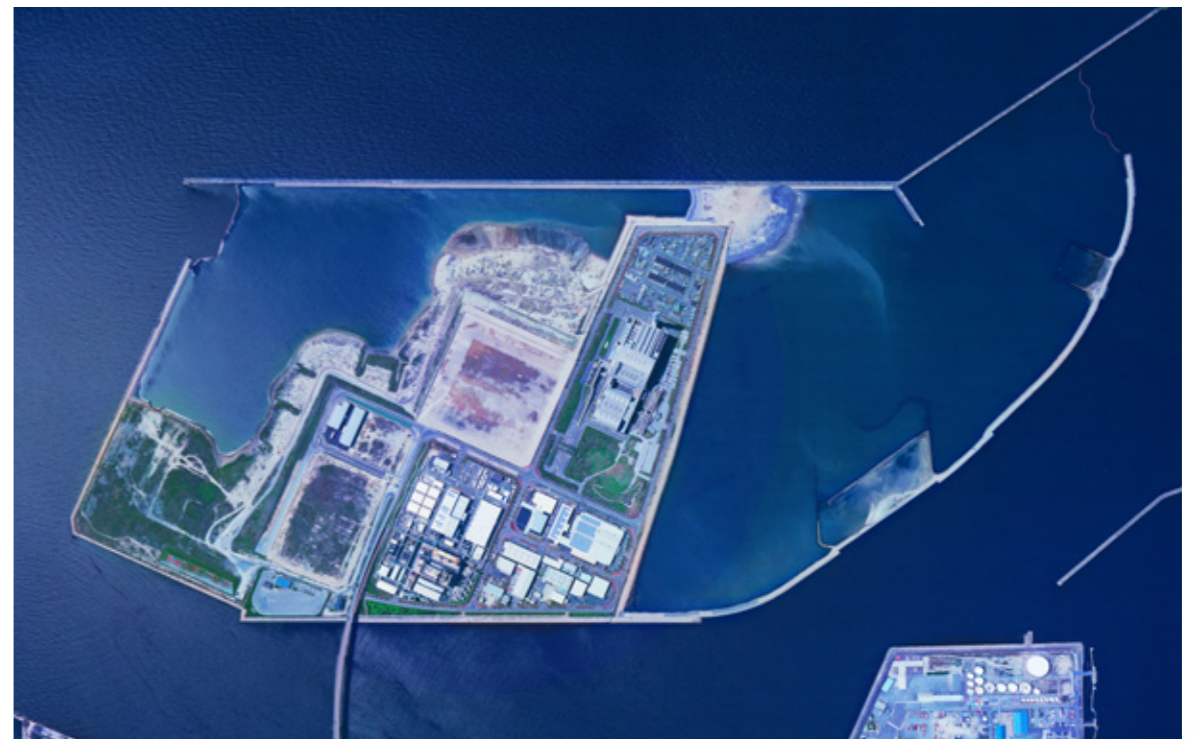
平成27年4月 第5-3-1-1区(第2期製造業用地の一部)が竣工しており、第4-1区(第1期保管施設用地の一部)では進出企業が操業中です。暫定緑地の陸地化が完了し、その南側の西側臨海緑地で、粗大礫等による埋立が行われています。建設発生土累積埋立量は、1,000万トンに達しました。
