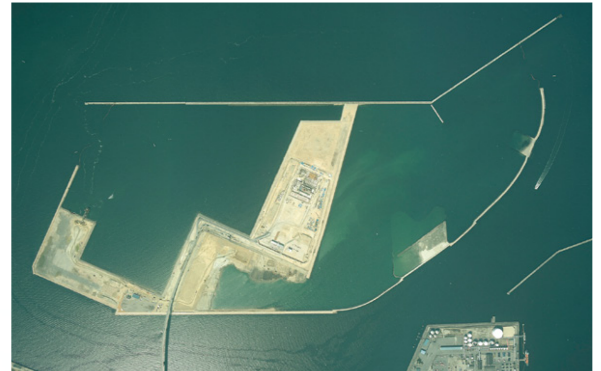
平成16年3月 南干潟(人工干潟)が完成しています。購入土(山土)等を用いて竣功した第1-2区では、建設発生土受入基地が建設中です。第3-2-2区(第1期製造業用地)の埋立て進行中です。
