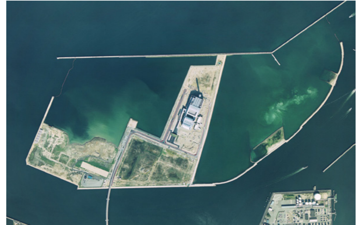
平成18年9月 第4-1区(第1期保管施設用地の一部)の埋立が進行中です。建設発生土累積埋立量は、500万トンに達しました。
