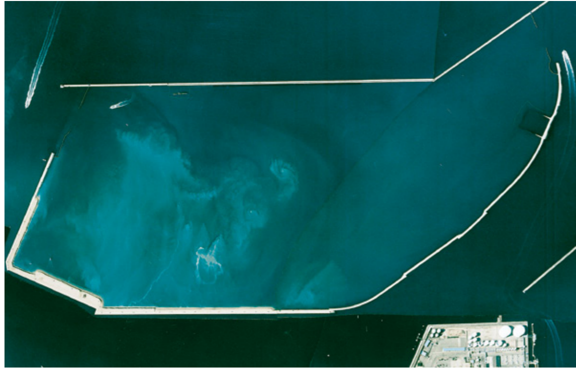
平成11年11月 外周護岸が概成した後、埋立土砂の投入を開始しました。土砂の投入方法は、護岸開口部から進入させた土運船による直接投入方式です。
