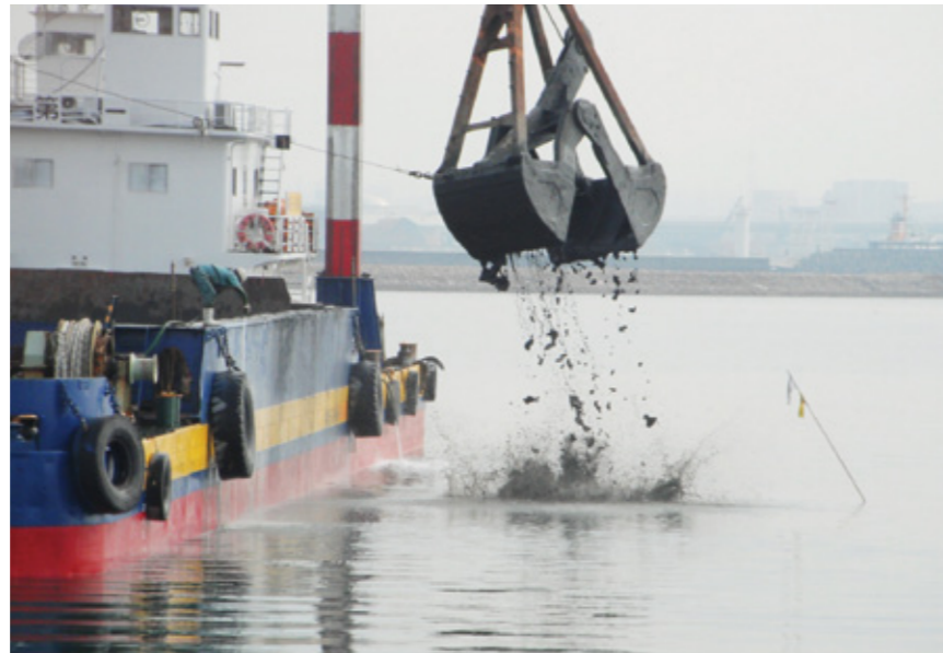
浚渫土砂の投入(密閉式土運船)
