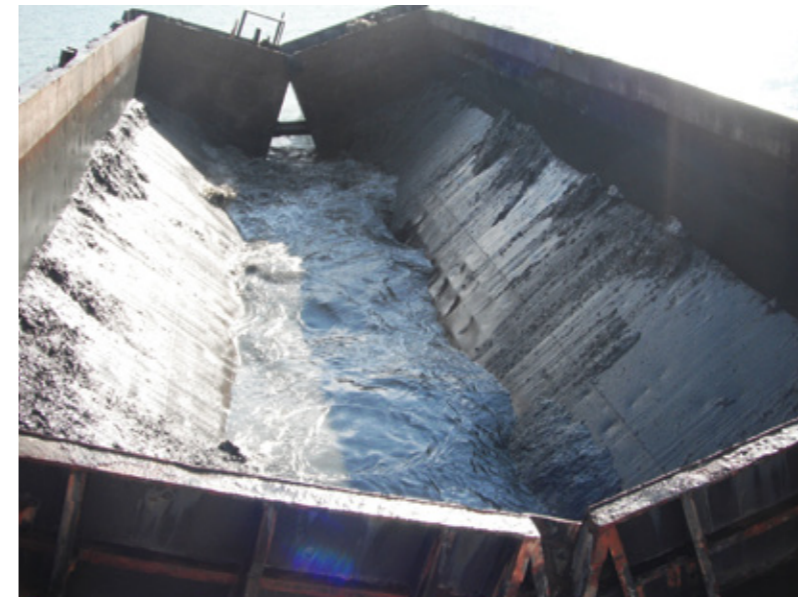
浚渫土砂の投入(底開式土運船)
