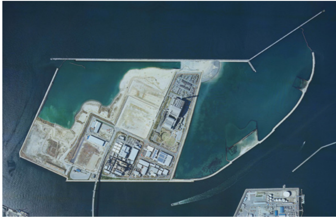
平成28年2月 第5-3-1-2区の陸地化が完了しています。建設発生土埋立区域は、第5-3-1-2区から第4-2区(第1期保管施設用地の一部)へ変更されています。
